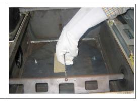
☐ Wärmetauscherdeckel und Brennraumdeckel demontieren um Gewicht weiter zu verringern
