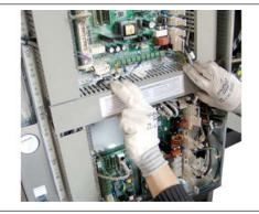
☐ Abdeckung des mittleren Kabelkanals abnehmen
