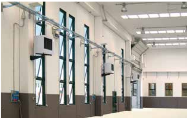
GasaTherm mit drehbarer Wandkonsole (Sonderzubehör).
