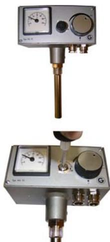
Le limiteur de température de sécurité (STB) éteint la chaudière à une température maximale de 100 °C environ. Dès que la température chute en dessous de 75 °C environ, le limiteur de température de sécurité peut être déverrouillé mécaniquement.
