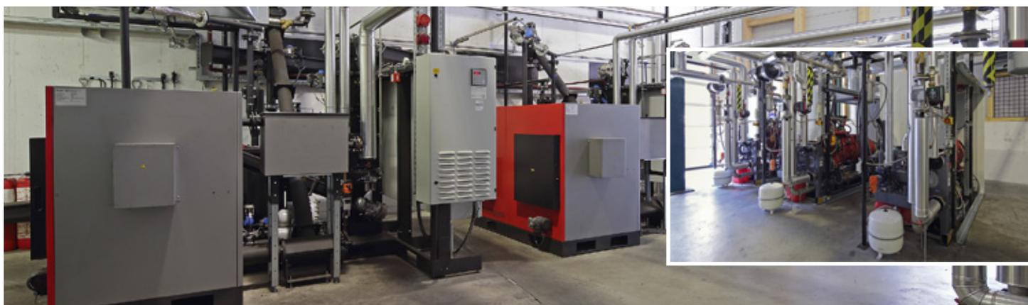
Conçu au départ pour une capacité de trois installations, le quatrième gazogène du projet a été installé à l'été 2016. Au cours de la première année de fonctionnement, après exactement 365 jours, chaque centrale de cogénération a fonctionné plus de 8 400 heures.
