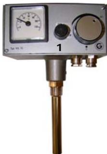
Der Sicherheitstemperaturbegrenzer (STB) schaltet den Kessel bei einer Temperatur von ca. 100°C ab. Nach dem Abkühlen des Kessels muss der STB händisch entriegelt werden:
