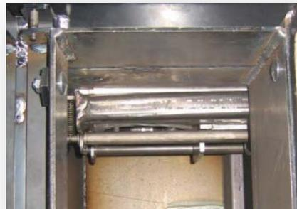
1. 8 à 25 kW : Ouvrir la porte isolante et la porte des cendres de droite et retirer le tiroir à cendres.
