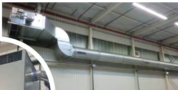
Papierlager: Beheizung mit zusätzlicher Schleierung Schleusenbereiche zwischen Lager und Produktion.
