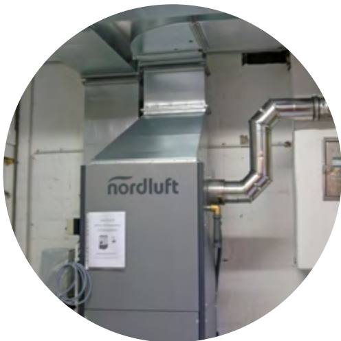
Zuluftanschluss und Abgassystem eines NL-A WO
