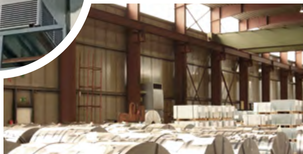
Metall-Coillager: Permanent-Beheizung zur Verhinderung von Rostbildung.
