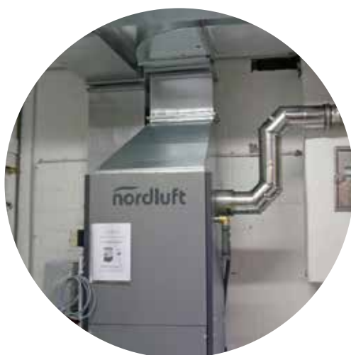
Raccordement d'air d'alimentation et système d'évacuation des gaz d'échappement d'un NL-A WO
