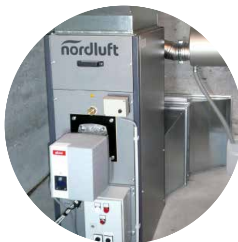
Raccordement d'air frais d'un NL-A WO
