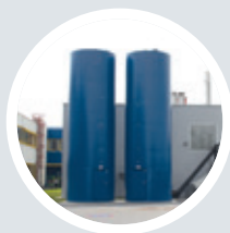
Silo en acier
