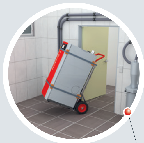
Plaatsing met behulp van een steekwagen
