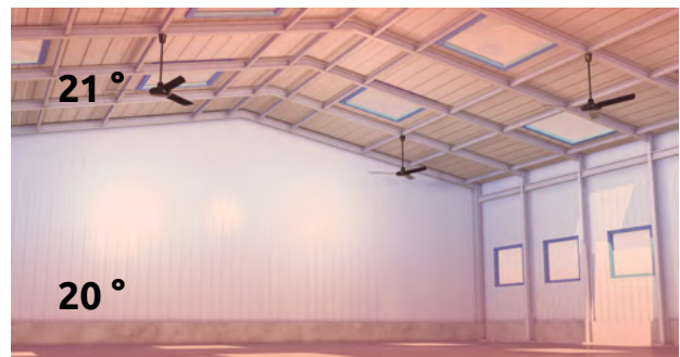
Wärmeverteilung mit Wärmerückführung
