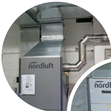
Zuluftanschluss und Abgassystem eines NL-A WO
