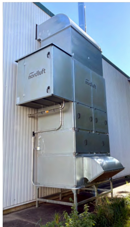
Wetterfester Warmlufterzeuger (18.400 m³/h, 230 kW) mit Mischkammer für Außen-, Umluft- und Mischluftbetrieb sowie integriertem Luftfilter zur Beheizung und Belüftung einer Getränkehalle.
