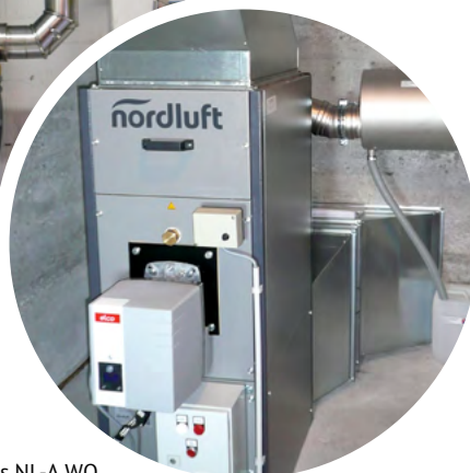
Zuluftanschluss und Abgassystem eines NL-A WO
