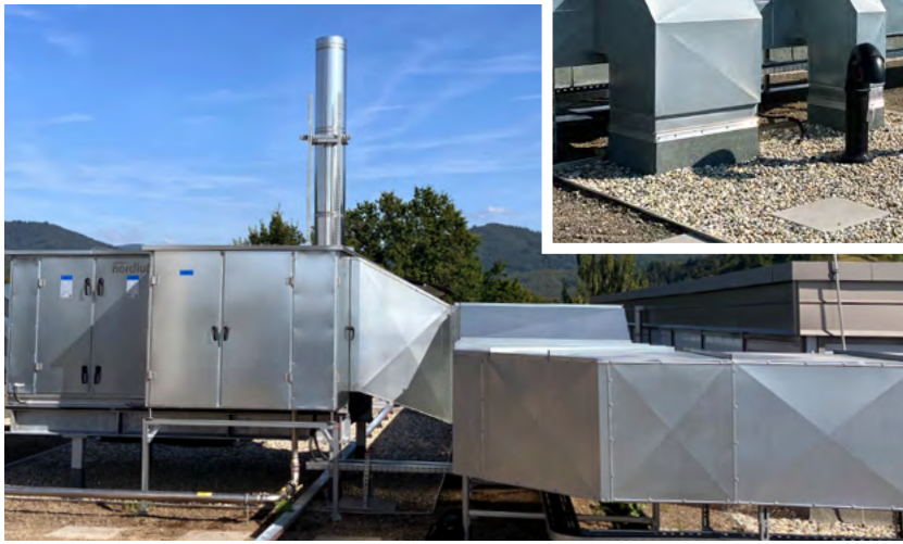
Warmfluterzeuger als Dachzentrale (26.500 m 3 /h, 300 kW) im Außenluftbetrieb mit Luftfilter zur Beheizung und Belüftung des Gymnasiums Oberkirch.
