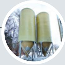
Blechsilos als Alternative Lagermöglichkeit für den Aussenbereich
